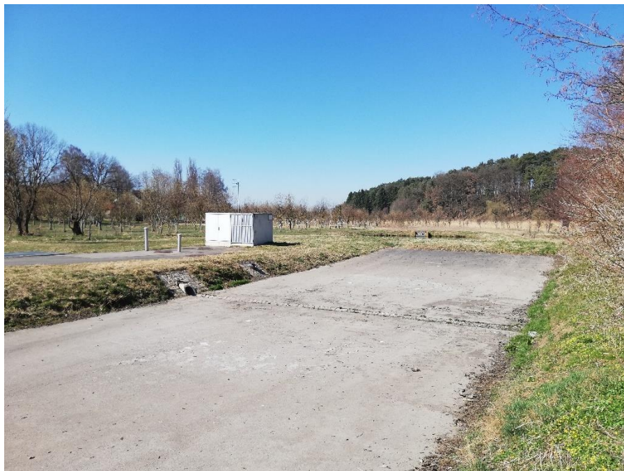
Abbildung 3-5 Regenüberlaufbecken mit Pumpstation Eulenried
