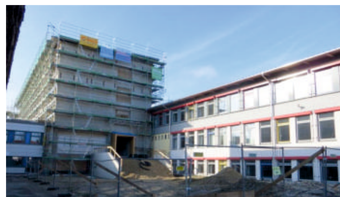
Die Sanierung der Realschule Pfaffenhofen läuft auf Hochtouren.
